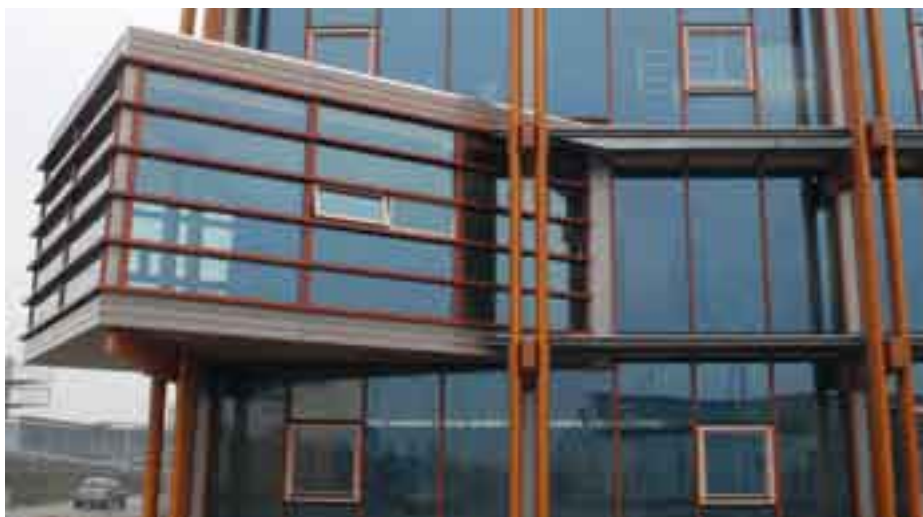
Opvallend is de uitkragende uitbouw.
